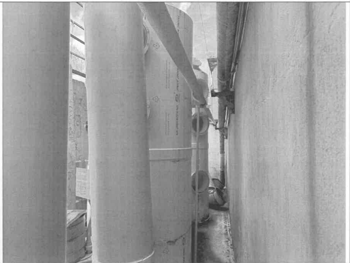
次氯酸钠氧化+碱液喷淋（污水站废气）
