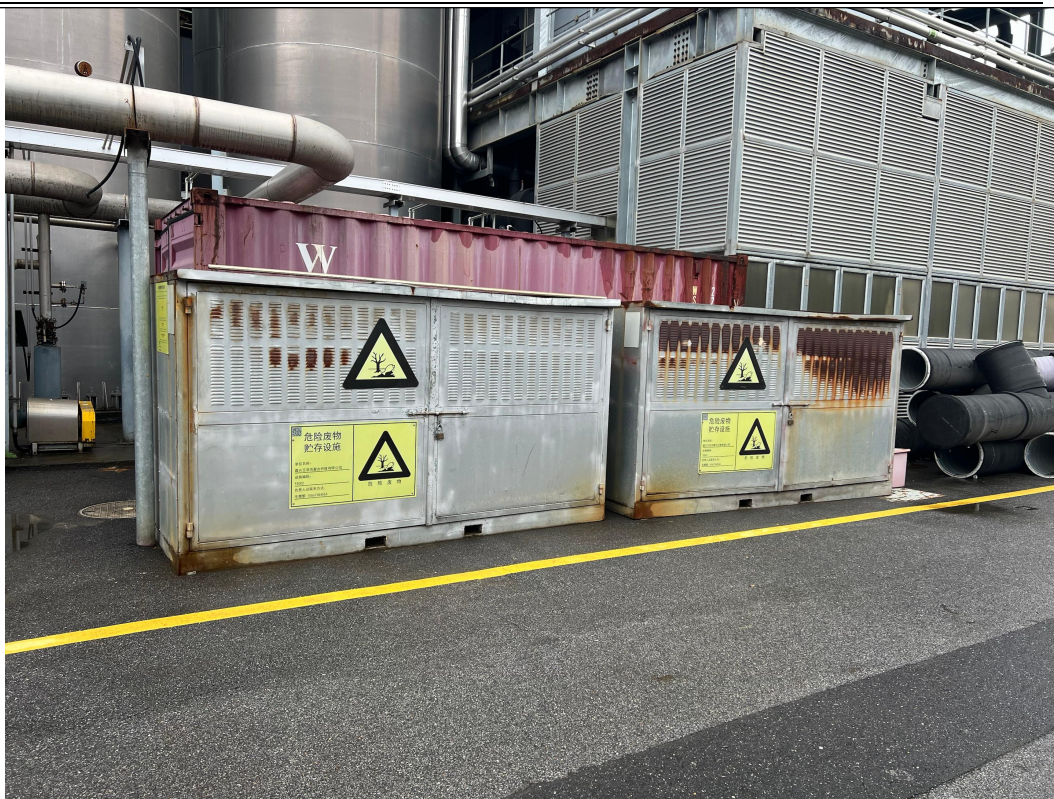
危废仓库外部照片 2
