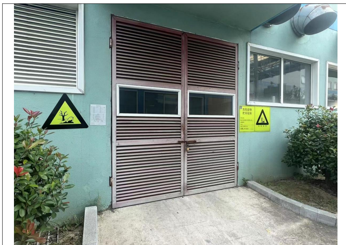
危废仓库外部照片 1
