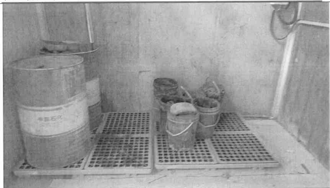
危废仓库内部
