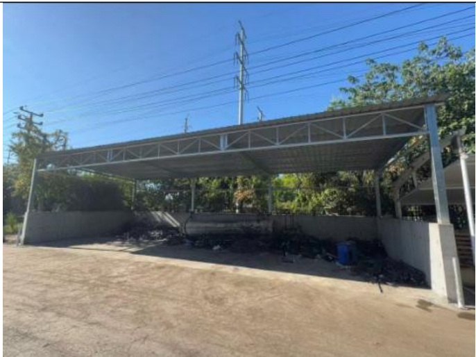
一般固废暂存场所
