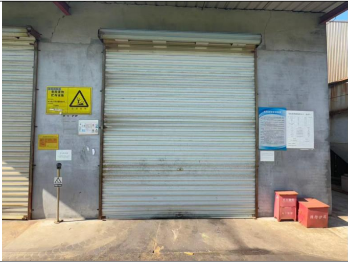
危废仓库外部照片
