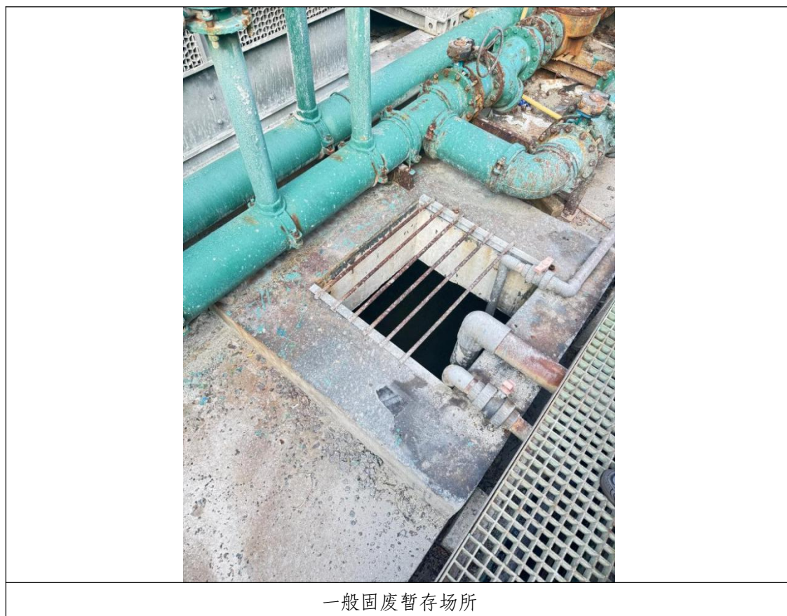
图 4-4 固废存放现场照片
